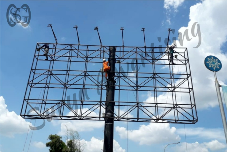
Konstruksi Pemasangan Rangka Besi
