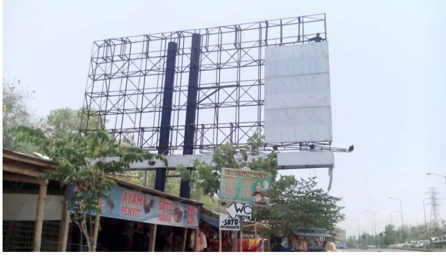
Konstruksi Pemasangan Plat Almunium
